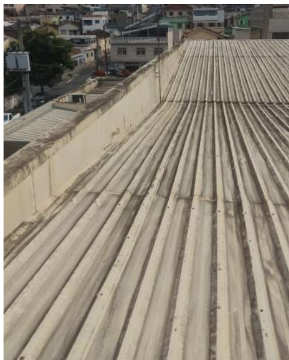
Foto 15 - Telhado sem interligação entre as águas:
