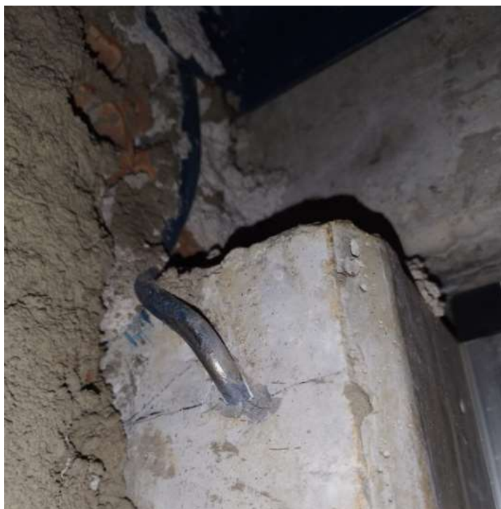
Foto 18 - Descida em aço carbono interna ao pilar
