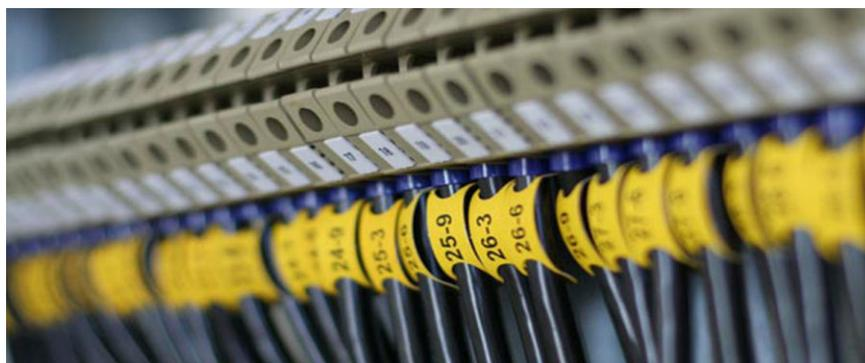
Figura 2: Identificação dos condutores com tags (etiquetas).
