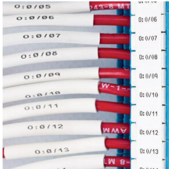
Figura 3: Identificação dos condutores com luvas termorretráteis.
